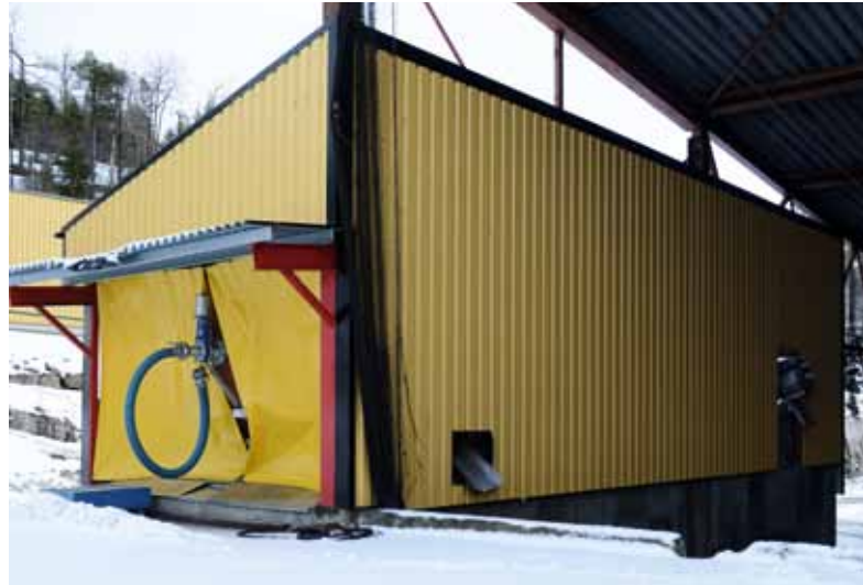
Nytt bygg for septikavvanning
