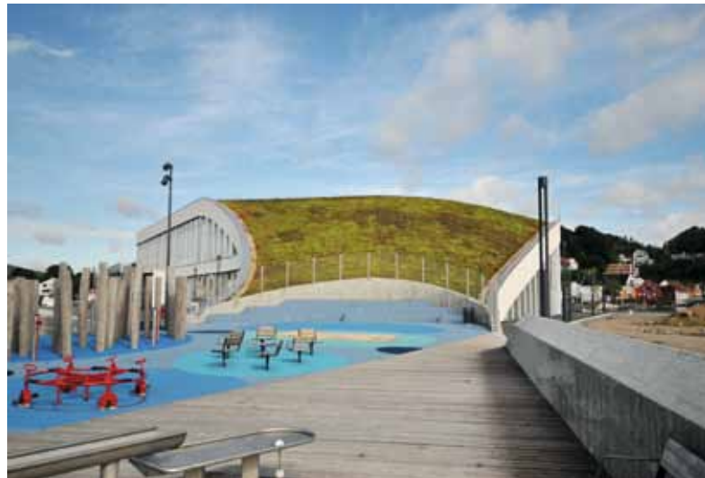
Sedum Jord fra Grønn Vekst Sør lagt på taket på Buen Kulturhus i Mandal.
