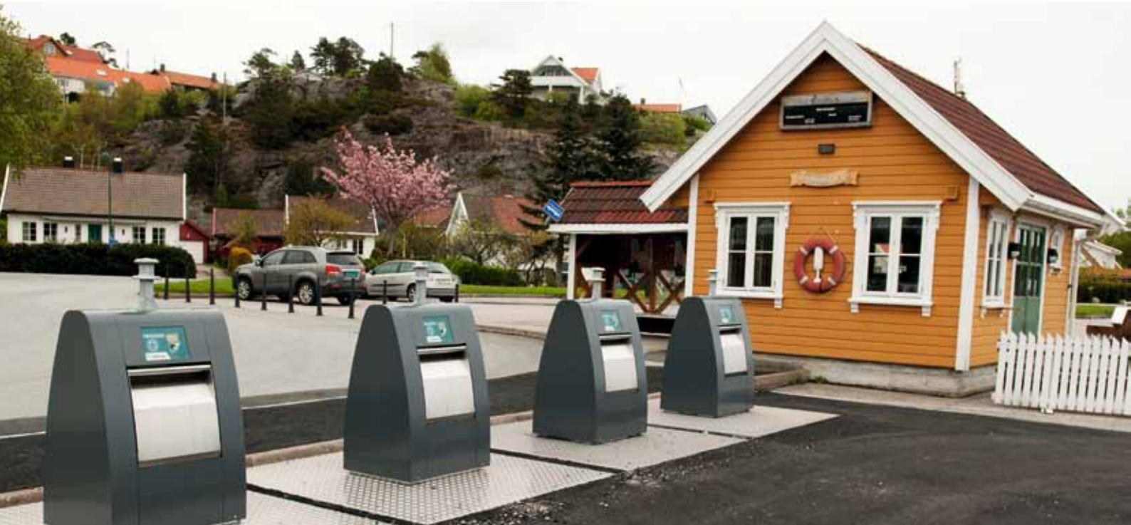
Nedgravde containere ved båthavna på Høllen Brygge i Søgne
