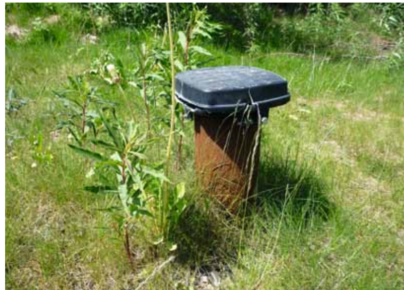
Prøvebrønn ved nedlagt deponi
