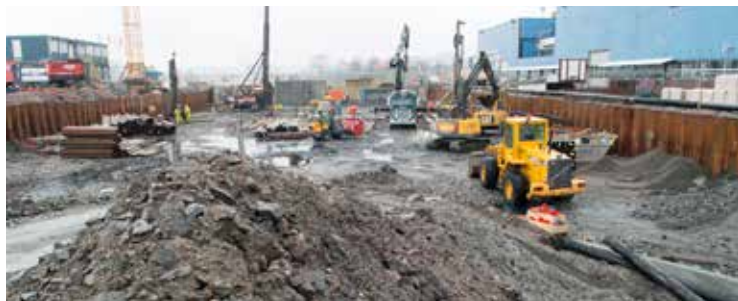
Forurensede masser fra utbyggingen på Tangen i Kristiansand ble kjørt til deponi på Støleheia.
