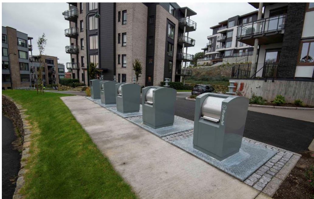
Figur 3.4 Eksempel på avfallspunkt med nedgravde containere
